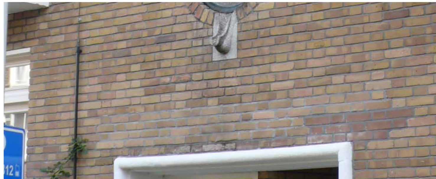
In kleur niet aansluitend voegwerk, te lichtgrijs. Tevens onvoldoende terugliggend voegwerk
