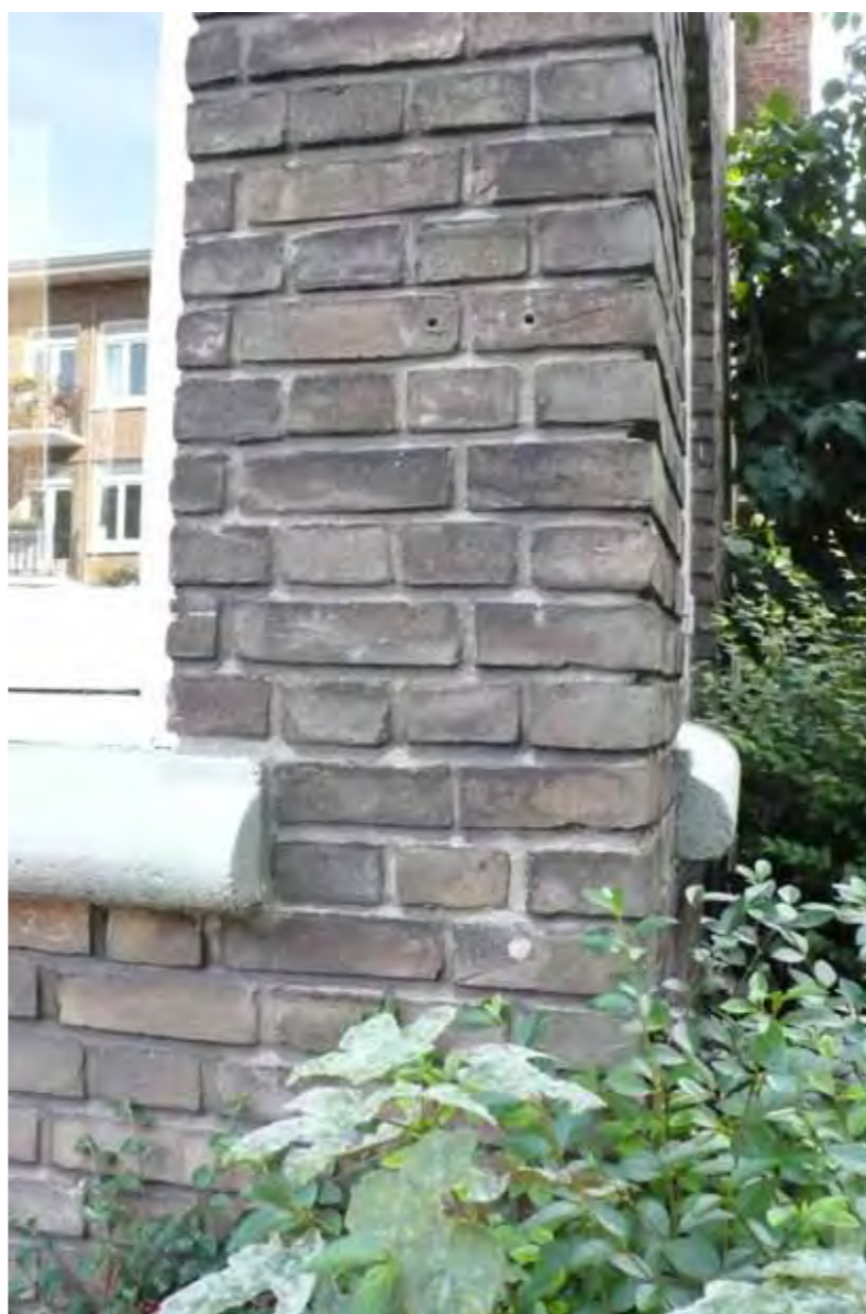
Doorgestroken voeg iets verdiept toegepast
