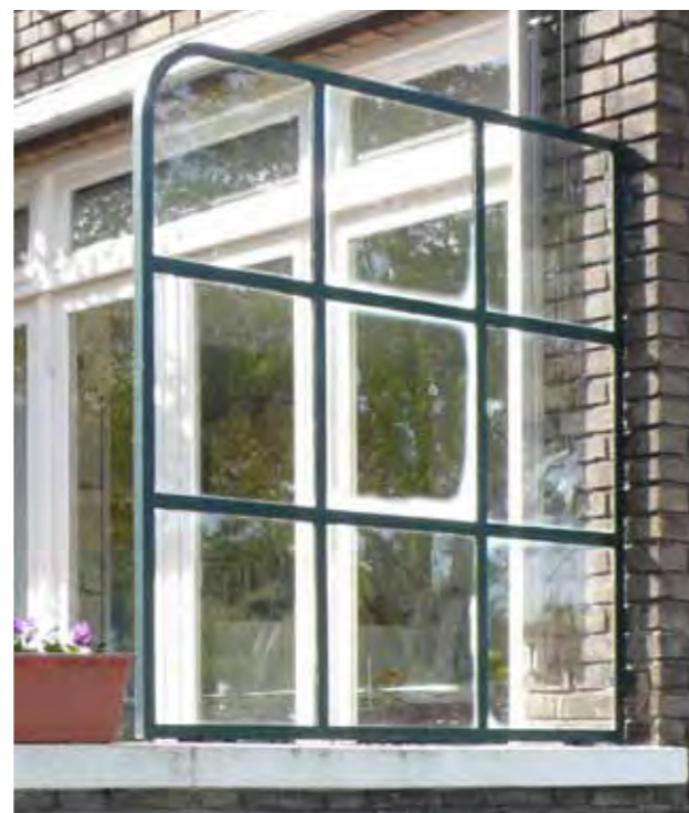
foto origineel scheidingscherm met enkelglas
