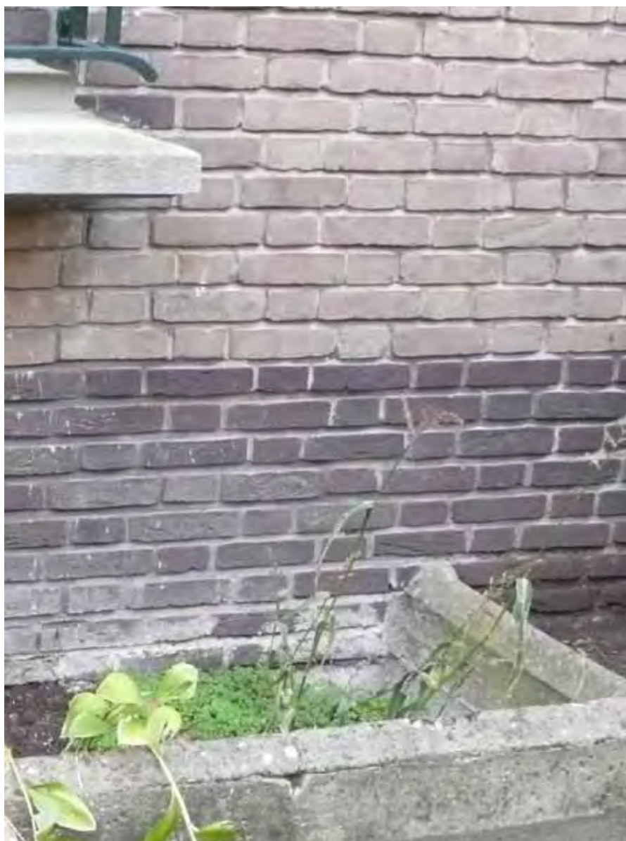
Roodpaarse plint en gele baksteen in vlaams verband
