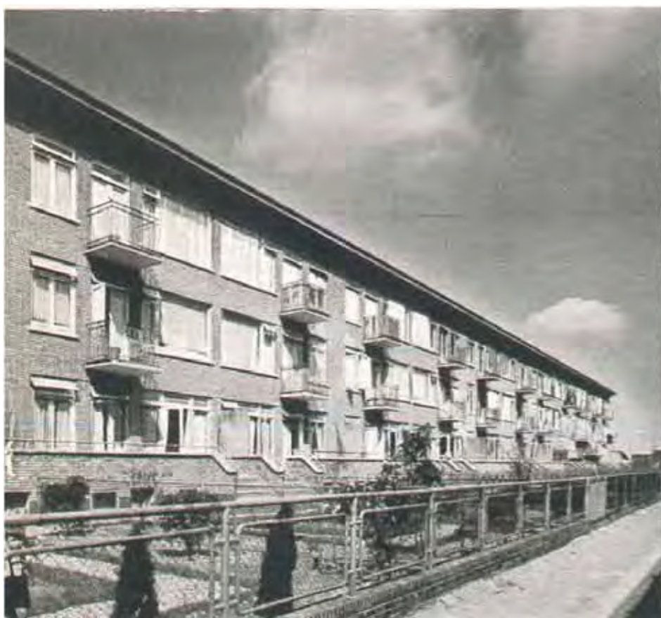
Foto achtergevels aan de straat met hekwerk afgeschermd, dd rond 1939
