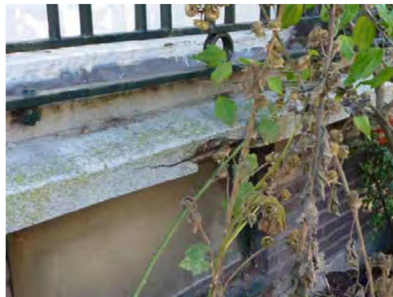
diverse voorbeelden van betonschade in het Jaffacomplex
