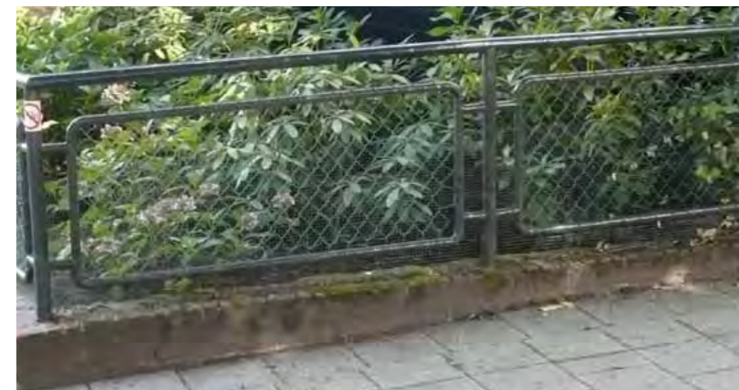
foto origineel tuinhek met diagonaal gespannen gaas.
